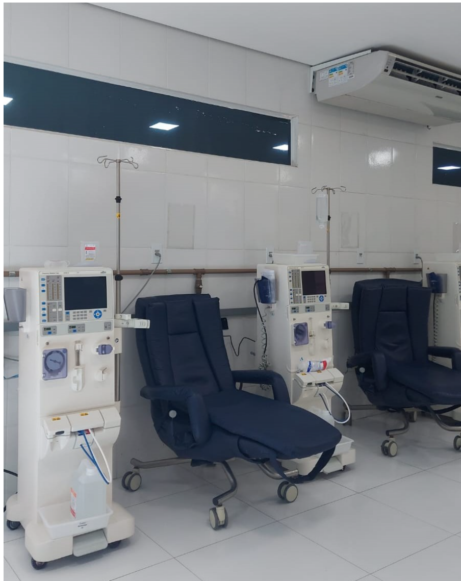
Imagem 18: Vista da janela alta da Sala Branca de diálise. Fonte: Autora
