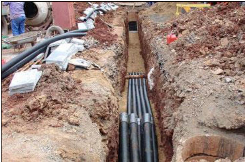
**Figura 2.6.** Rede Subterrânea de um condomínio com cabos isolados; Fonte: Infraroi, (2018).
