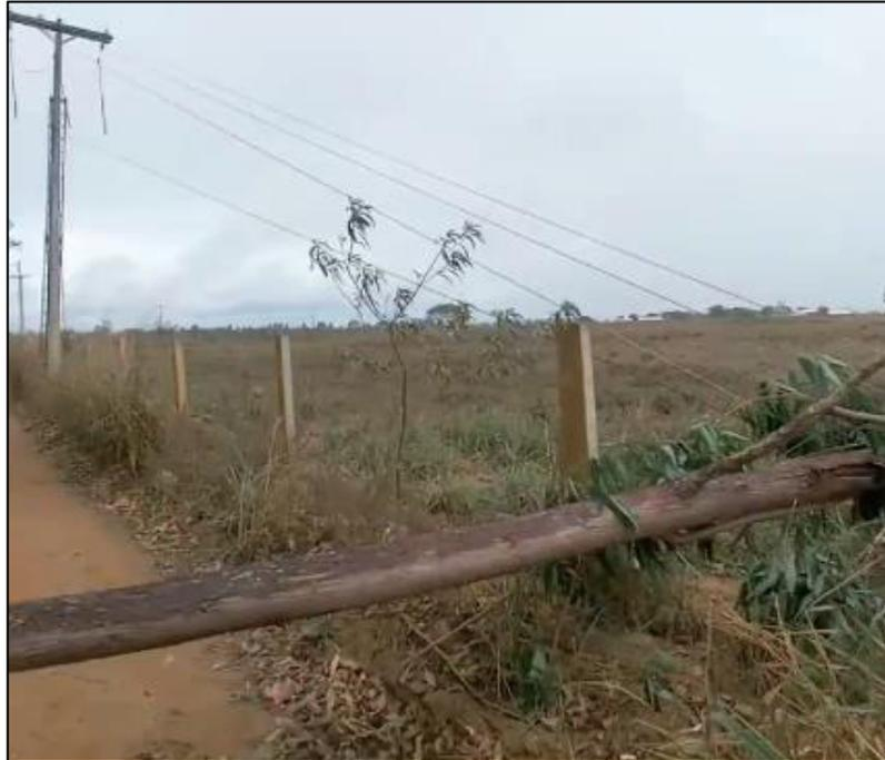
**Figura 6.8.** Eucalipto sobre linha de distribuição. Fonte: Próprio autor (2023).
