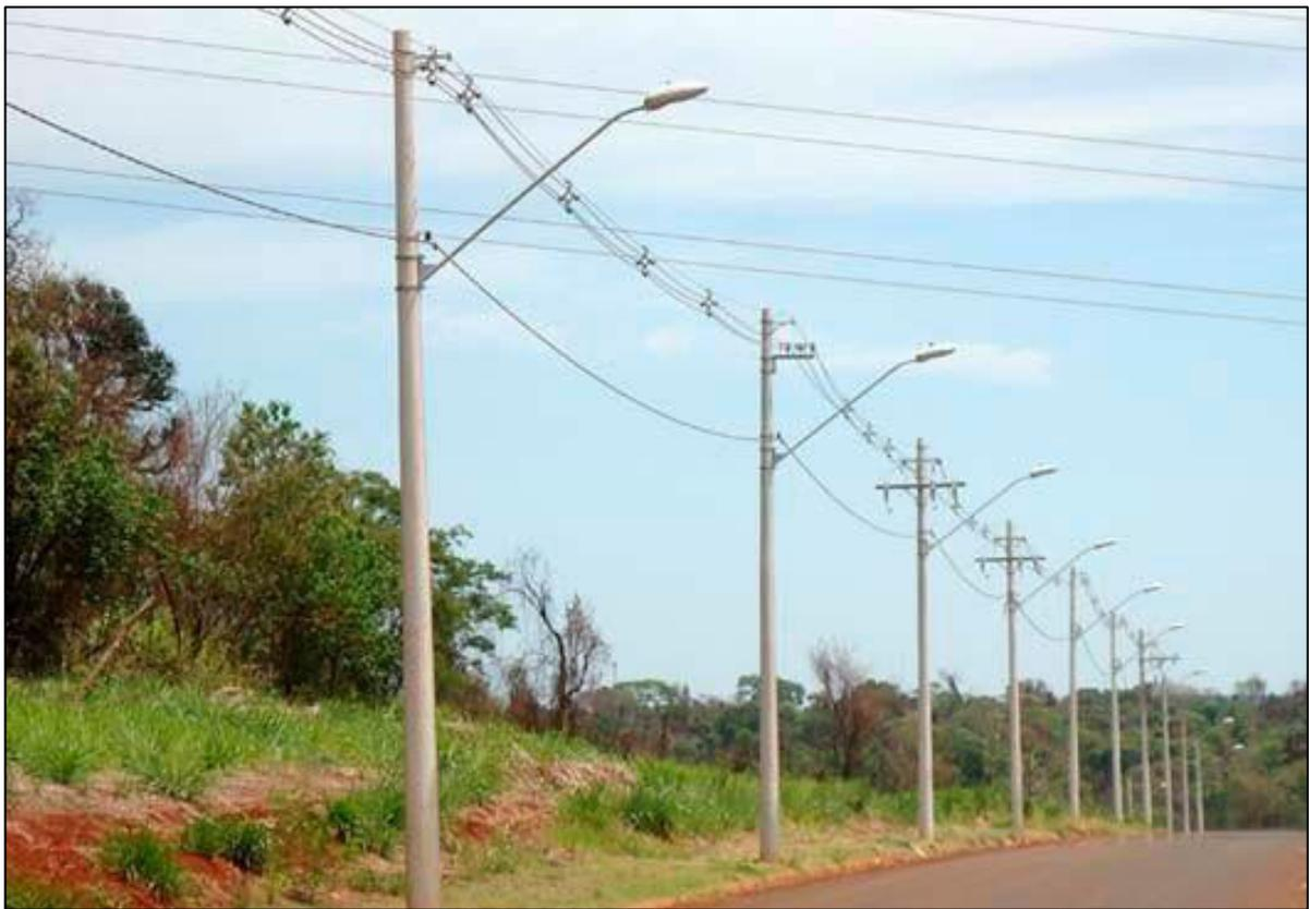
**Figura 2.4.** Rede de distribuição compacta com espaçadores losangulares. Fonte: Ancora Industrial, (2023).
