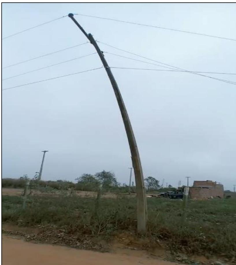
**Figura 6.10.** Poste fletido devido a força de tração dos condutores. Fonte: Próprio autor (2023).
