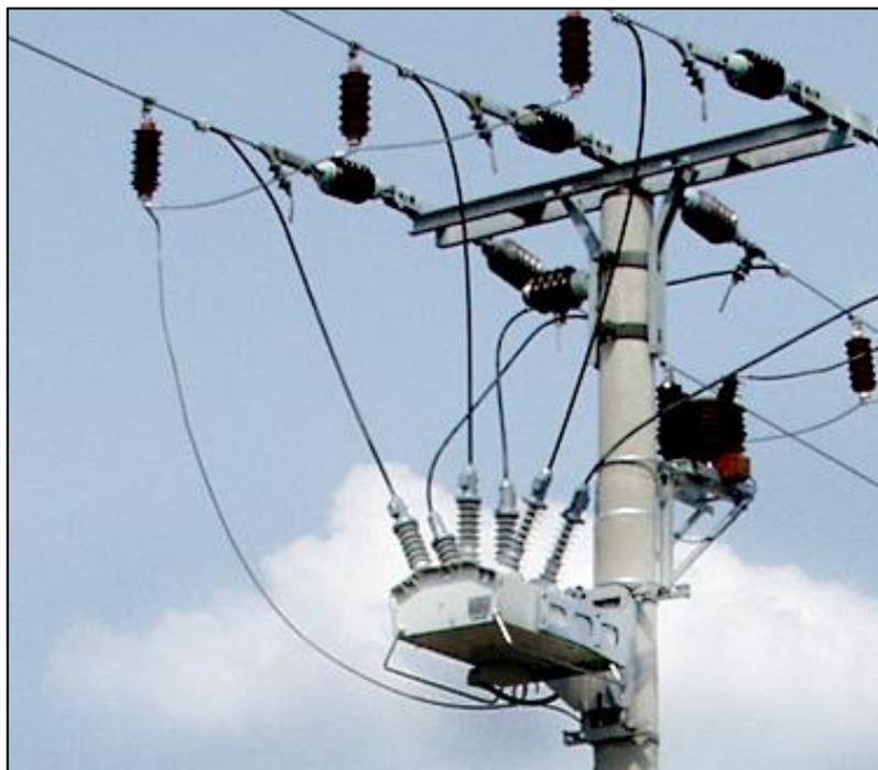
**Figura 2.9.** Religador Automático instalado na rede de distribuição. Fonte: Adolphoeletricista, (2023).
