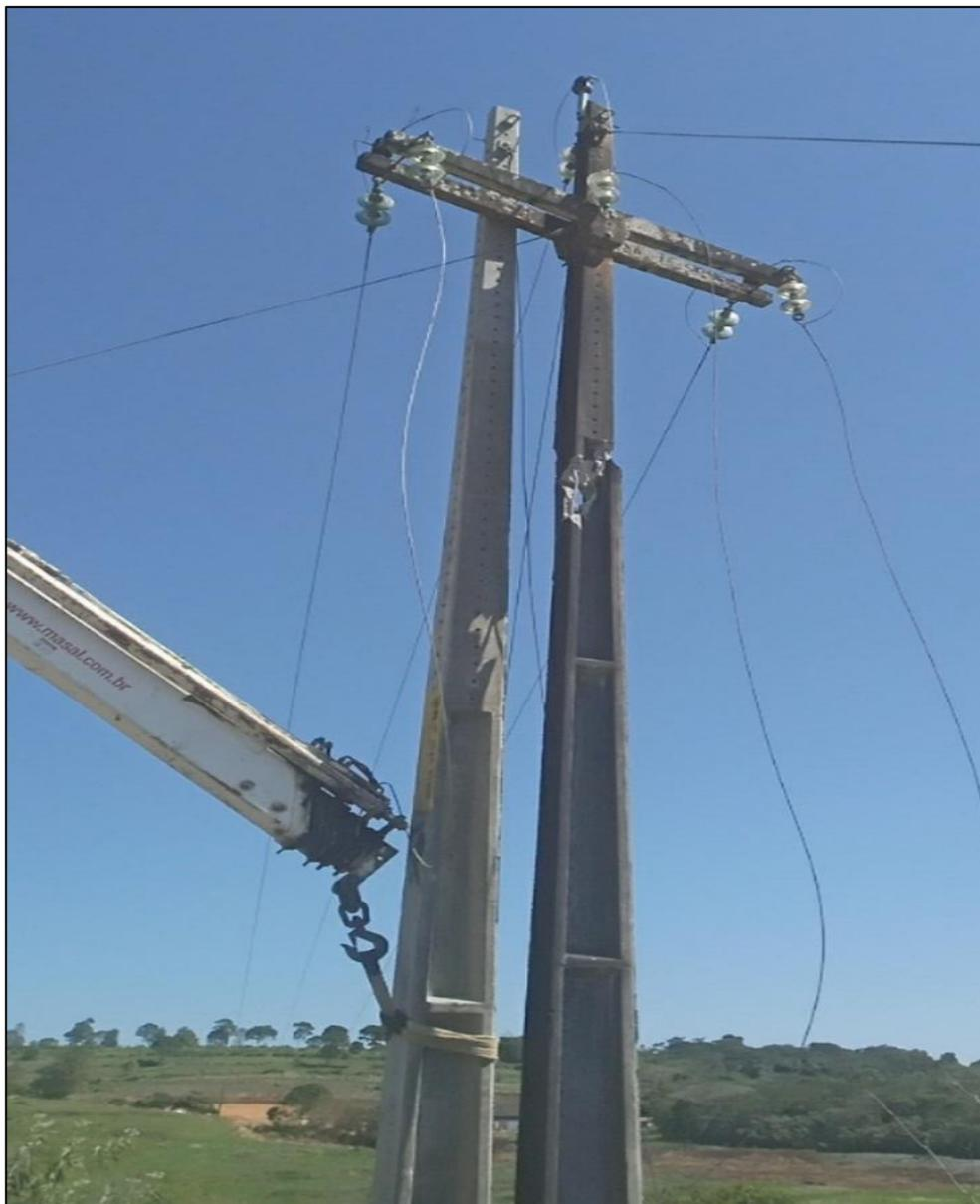
**Figura 6.5.** Substituição do poste danificado por uma nova estrutura. Fonte: Próprio autor (2023).
