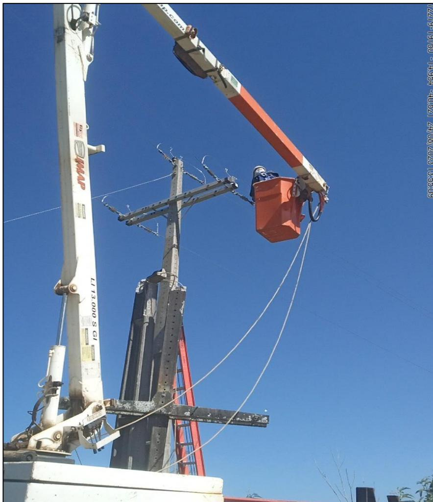
**Figura 6.6.** Instalação dos isoladores e cabos para o novo poste. Fonte: Próprio Autor (2023)
