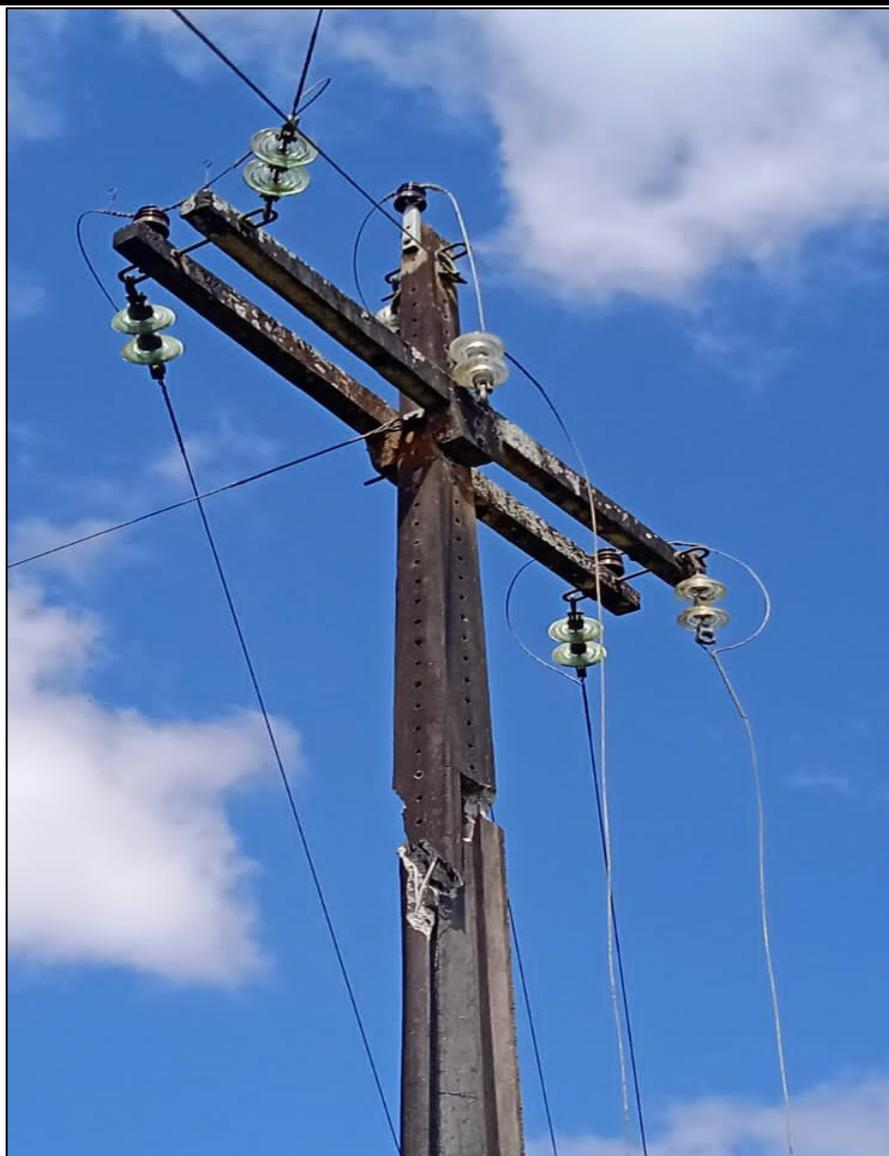
**Figura 6.3.** Poste danificado devido ao tensionamento de condutores. Fonte: Próprio autor (2023).
