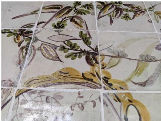
**Figura 92** – Detalhes do painel  $\surd$ , onde não é possível distinguir o azulejo original da reconstrução.
