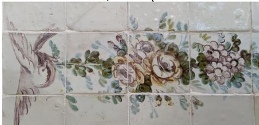
**Figura 97** – Rejunte se desprendendo, fissuras e craquelês no vidrado do painel **X**.
