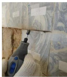
**Figura 111 –** Remoção do azulejo com a argamassa de fixação da parede de suporte.
