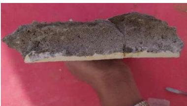
**Figura 112 –** Argamassa cimentícia presa no tardo do azulejo, identificada pela sua cor escura e dureza.
