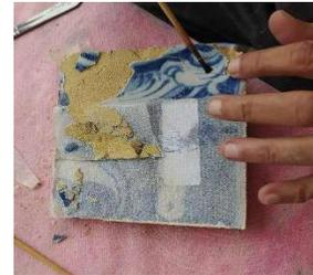
**Figura 116** – Processo de fixação vidrado que está descolando
