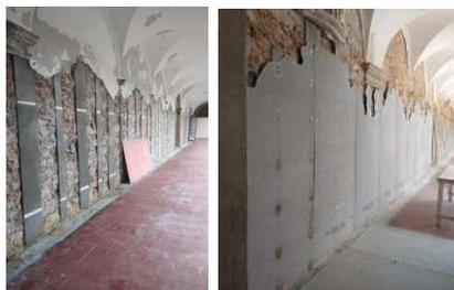
**Figura 124** – Instalação dos azulejos nas placas.
