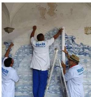
**Figura 110 –** Remoção do rejuntamento entre os azulejos.
