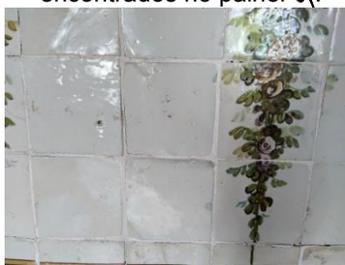
**Figura 94** – Alteração cromática e craquelês no vidro do painel  $\alpha$ .
