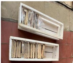
**Figura 113** – Azulejos armazenados após terem sido removidos do suporte.
