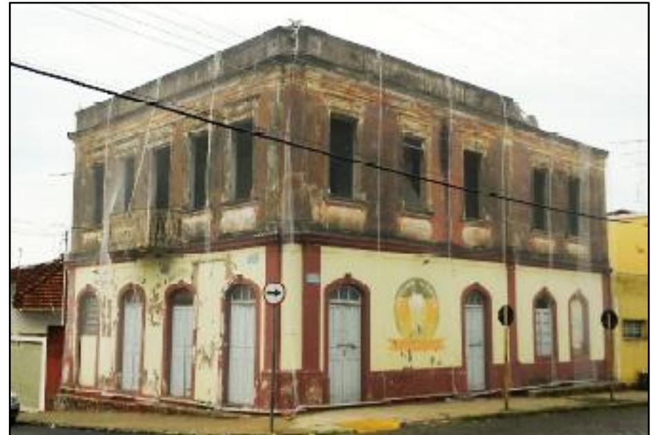
Figura 38 - Sobrado Chiaramonte após retirada das esquadrias do pavimento superior
