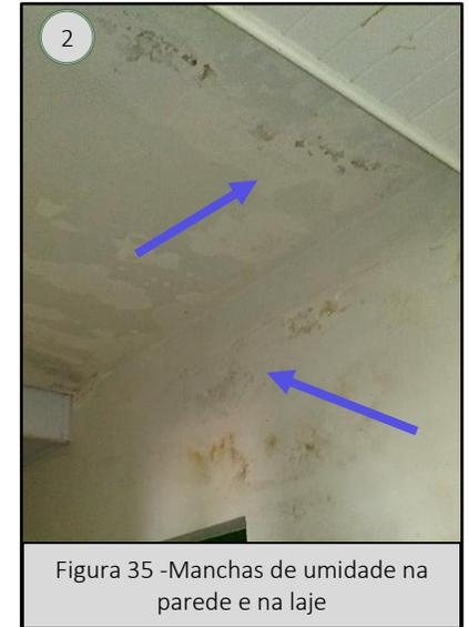
Figura 35 - Manchas de umidade na parede e na laje
